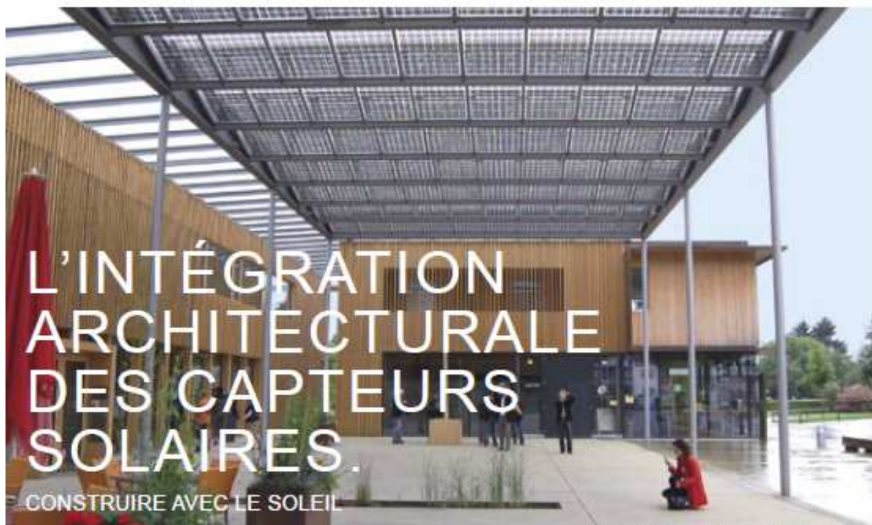
Un vélum de capteurs photovoltaïques abrite une place publique, Ludeach (Vorarlberg, Autriche) © CAUE 78
