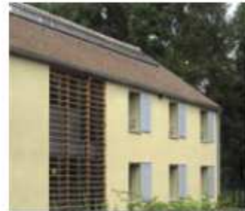
Un ensemble de capteurs thermiques souligne le faîtage de la toiture. Centre médicalisé à Bulfin (Yvelines). Cabinet Méandre, architectes © PNR Haute Vallée de Chevreuse
